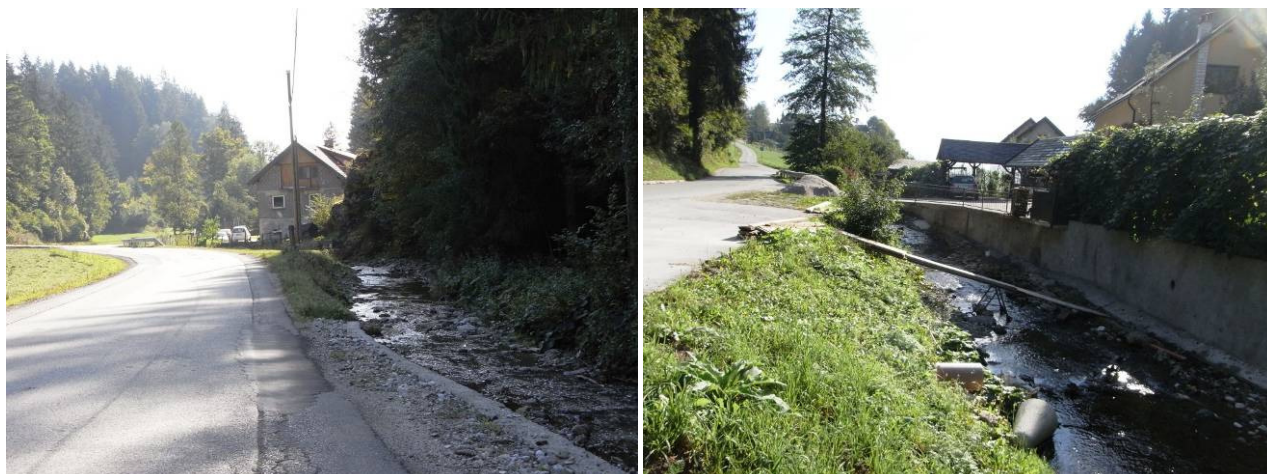
Sliki 13 in 14: Florjanščica v km 1.1 – levo; km 0.8 - desno (poplavno ogroženi objekti, desno viden rekonstruiran mostiček) (foto: D. Lajevac, sep 2013)
