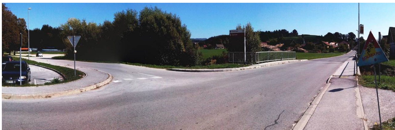
Slika 30: Premostitev Klančnice (Bečovnioce) gorvodno od sotočja s Pako, levo cesta proti nogometnem igrišču (foto: D. Lajevc, sep 2013)
