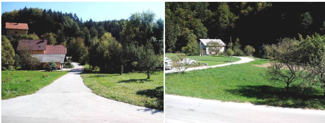
Sliki 45 in 46: Poplavno ogroženi objekti v km 2.10 – levo in km 2.34 – desno. (foto: D. Lajevac, sep 2013)
