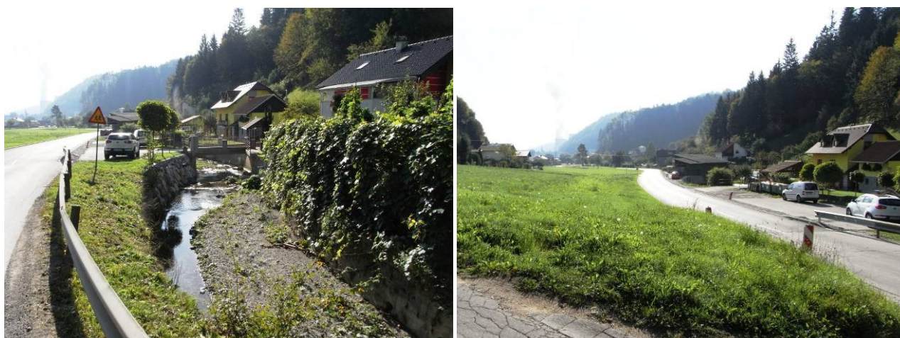
Sliki 15 in 16: Florjanščica v km 0.7 – levo; potencialno poplavne travniške površine desno (poplavno ogroženi objekti) (foto: D. Lajevac, sep 2013)
