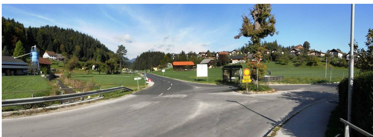
Slika 17: križišče pri naselju Florjan, v območju katerega teče Florjanščica (desno v ozadju vidne potencialno možne poplavne površine) (foto: D. Lajevac, sep 2013)
