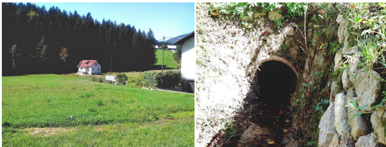
Sliki 27 in 28: Potencialno poplavno ogroženi objekt v km 3.5 – levo in vtok daljše zacevitve na območju Term Topolščica - desno (lokacija struge označena) (foto: D. Lajevac, sep 2013)
