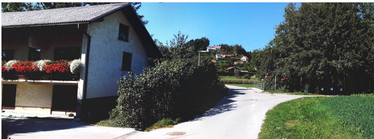
Slika 44: Poplavno ogroženi objekt ob Velunji v km 1.52 (foto: D. Lajevac, sep 2013)
