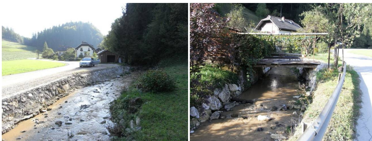
Sliki 12 in 13: Florjanščica v km 2.0 – 2.2 (poplavno ogroženi objekti); levo vidna sanacija brežine, desno – poddimenzionirane premostitve (foto: D. Lajevc, sep 2013)
