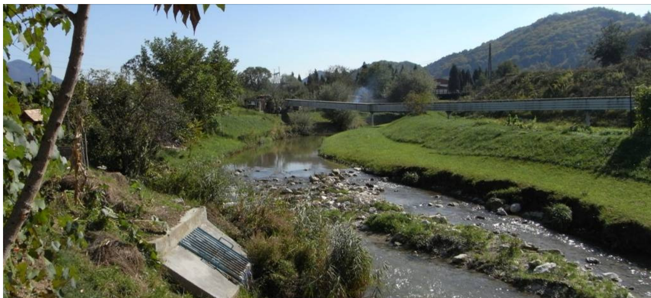
Slika 55: Predvidena lokacija umestitve razbremenilnega kanala, pogled gorvodno. (foto: D. Lajevce, sep 2013)
