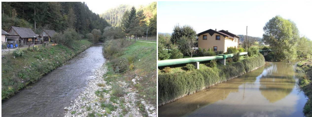
Sliki 4 in 5: Struga Pake dolvodno in gorvodno od mostu na cesti Šoštanj – Šmartno ob Paki, desno v ozadju vidno sotočje s Toplico (foto: D. Lajevc, sep 2013)
