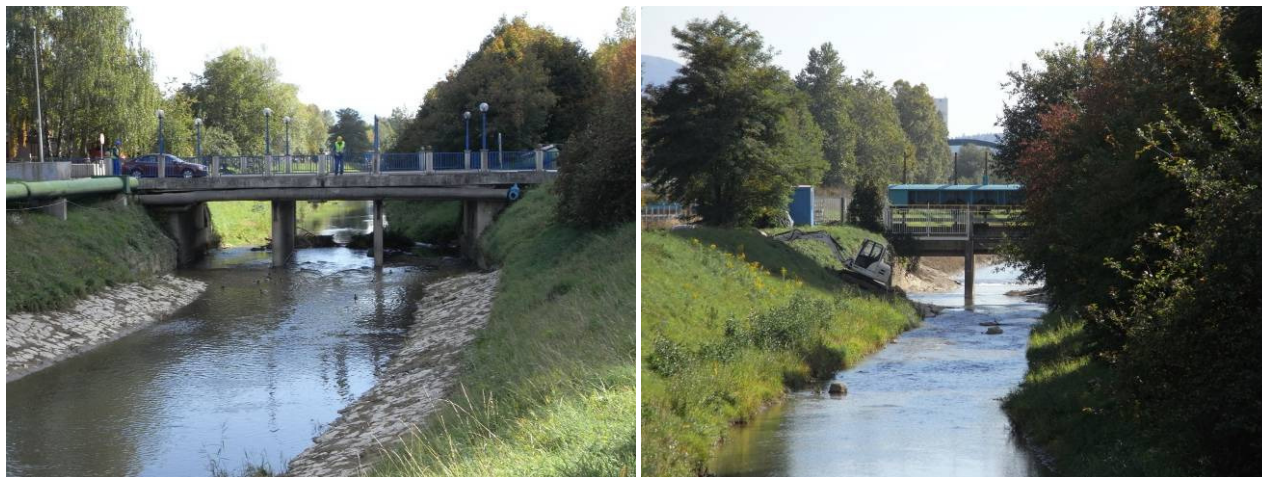
Sliki 10 in 11: Struga Pake v poteku skozi Šoštanj; levo –premostitev pri TEŠ, desno – zapornični objekt pri TEŠ (foto: D. Lajevc, sep 2013)
